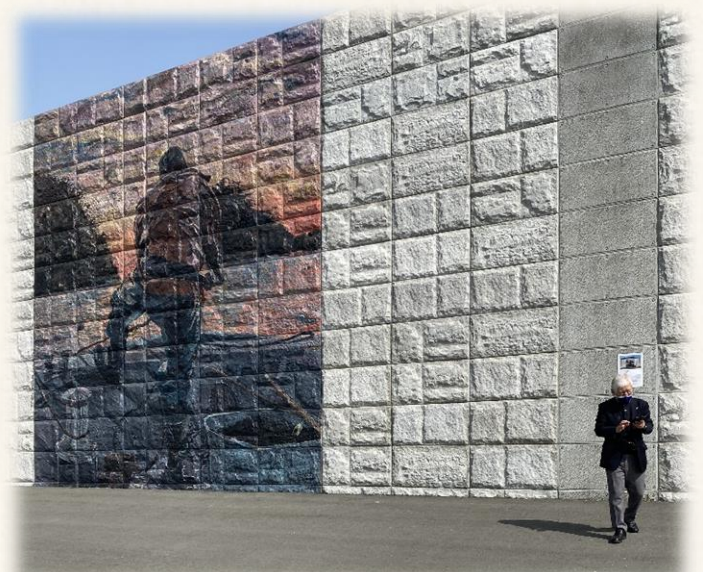
雄勝の防潮堤。高いところでは8mを超える高さの壁が、雄勝湾を囲んでいました。
