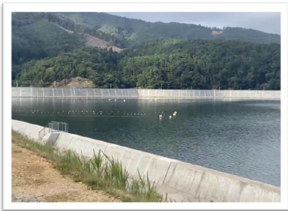
入り江の全体が防潮堤で囲われた、石巻市雄勝湾
