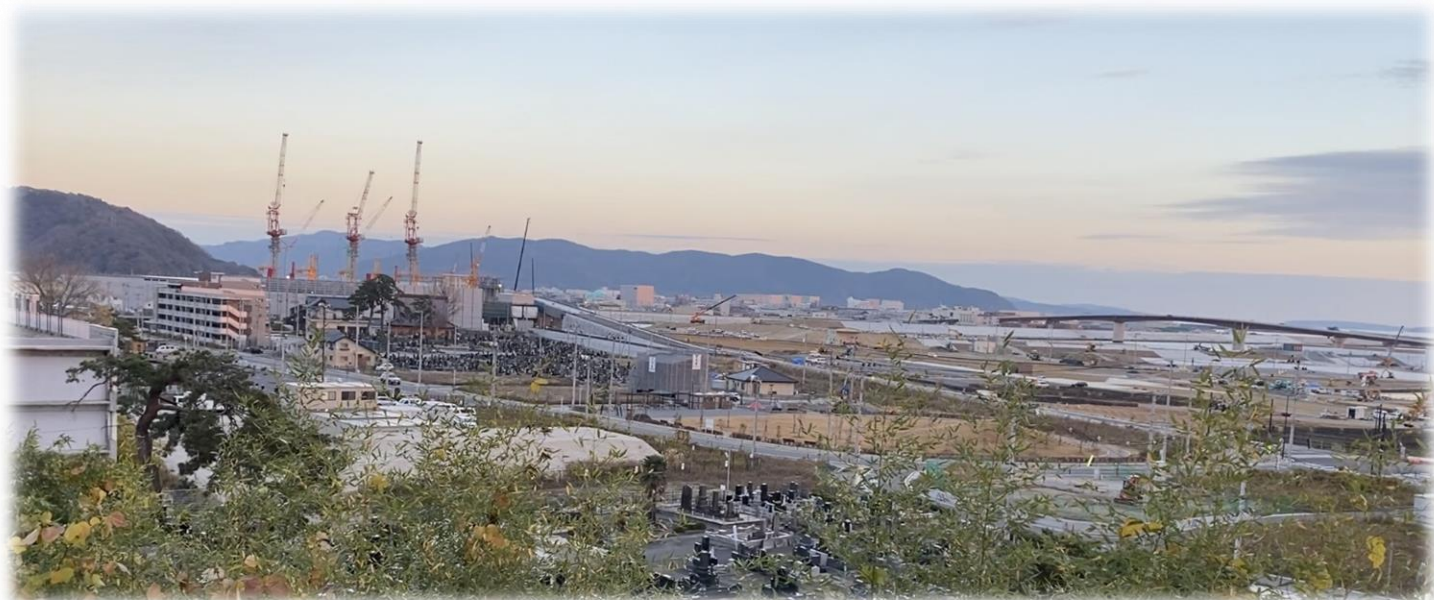
完成間近の「石巻南浜津波復興祈念公園」と「石巻かわみなと大橋」
